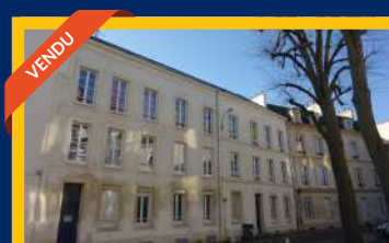
Immeuble de rapport - Caen Centre
